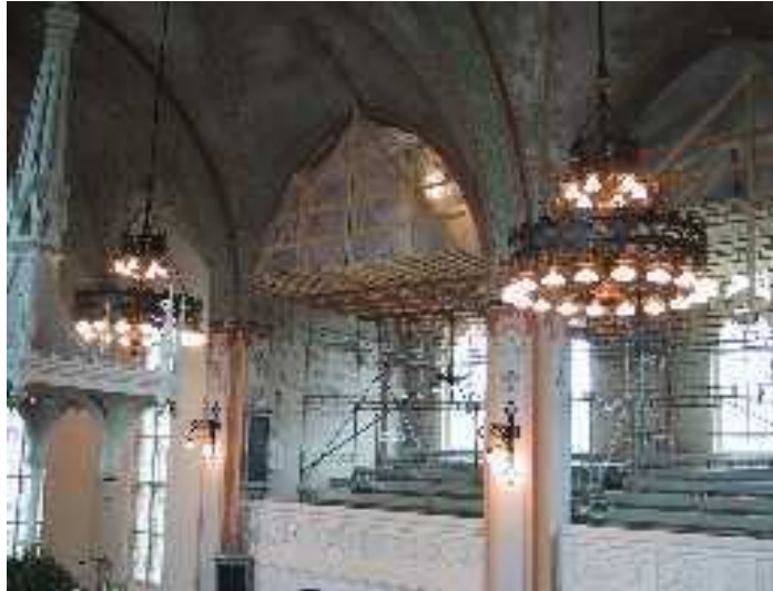
kuva 30: Kirkon sisätilan mittausten alue.
